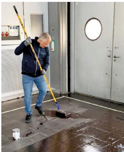
Neue Versiegelung bei der Sanierung eines abgenutzten Gussasphaltes.
