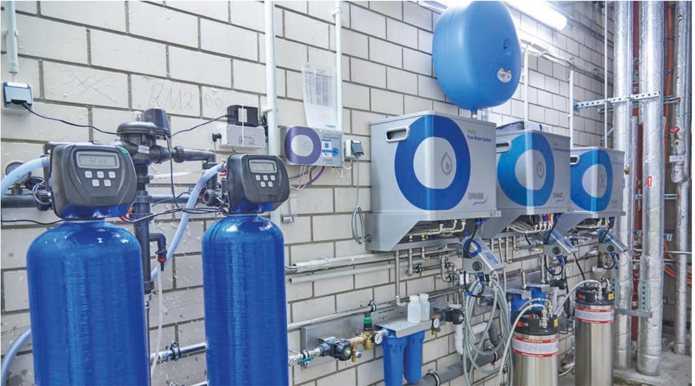
Eine mehrstufige Wasseraufbereitung garantiert eine sichere und keimfreie Luftbefeuchtung. (Foto: Condaïr)
