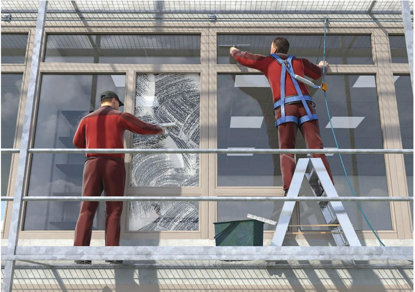
Gerüste sind eine bewährte technische Maßnahme zum Schutz gegen Abstürze, bei zusätzlichen Gefährdungen sind Persönliche Schutzausrüstungen gegen Absturz einzusetzen. (Foto: H.Zwei.S Werbeagentur GmbH/BG Bau)
